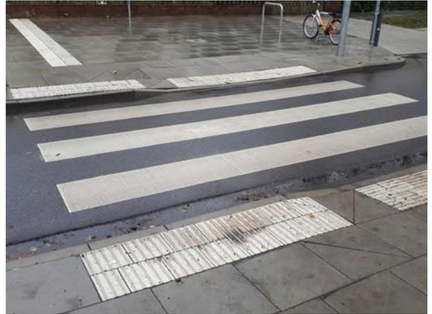
Rillensteine und abgesenkte Borde zur Querung am Knotenpunkt (hier im Bsp. an einem FGÜ)
