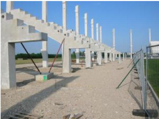
Das Stadion ist im Rohbau bereits fast fertig gestellt, d.h. die Tribünen und tragende Konstruktionen (Beton) sind erkennbar. Die Rasenfläche ist ebenfalls bereits vorhanden und wird regelmäßig gemäht. Die umliegenden Flächen sind überwiegend geschottert. Im südöstlichen Bereich stehen einige Baucontainer. Da die Baustelle zur Zeit still liegt, sind weitere Betriebsflächen und Maschinen nicht vorhanden.
