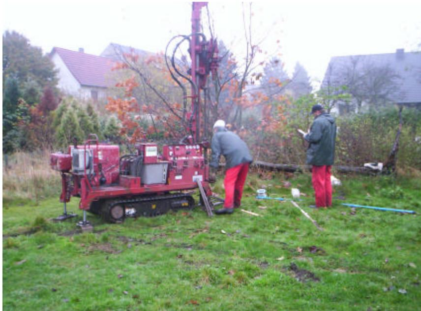
**Foto 7:** Blickrichtung SO; Ansatzpunkt BS 7 (Bohrgerät)
