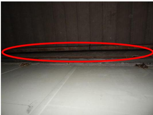
**Abb. 40 Spalt im Übergang der Decken von nördlicher zur südlichen Halle.**
