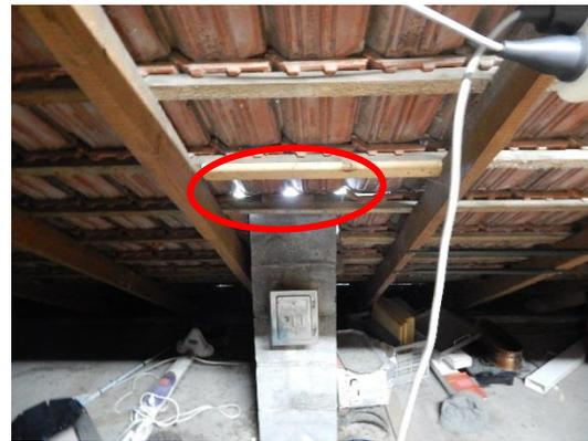
**Abb. 29 Einflugmöglichkeit an der Eindeckung des Walmdachs.**
