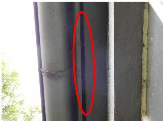
**Abb. 34** Spalt im Übergang von Dach zu Dachrinne.
