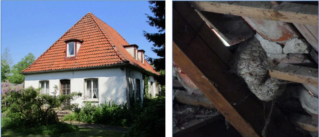
Abb. 3: Außenansicht des Hauses von Süden (Eingangsbereich) und Blick in einen Kniestock mit altem Wespennest und Lücken in der Dachdeckung.
