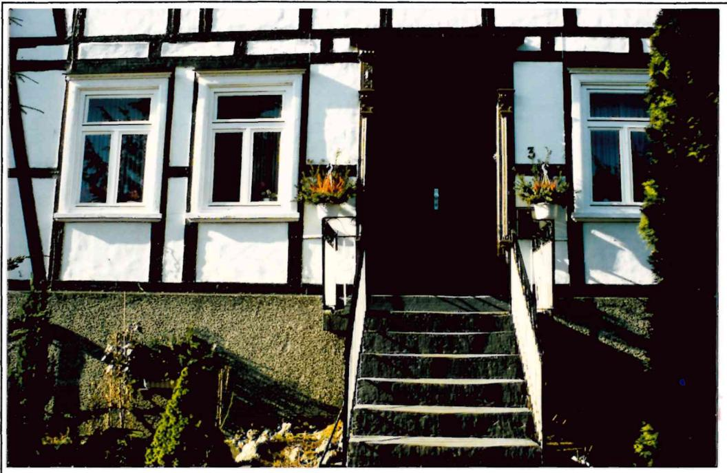
Zweiflügelige Originalholzfenster mit Oberlicht. Deutlich zu erkennen ist die Profilierung der Sprossen. Leider sind auf der rückwärtigen Gebäudeseite bereits neue Kunststoffenster eingesetzt worden, die die gestalterische Qualität und Proportion der Originale nicht annähernd erreichen.
