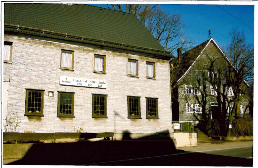
Dieses Gebäude wurde einmal durch falsche Sanierung grob entstellt: Preßbitumen an der Fassade und braune Fenster ohne richtige Sprossen führen zu einem wenig ansehnlichen Eindruck.
