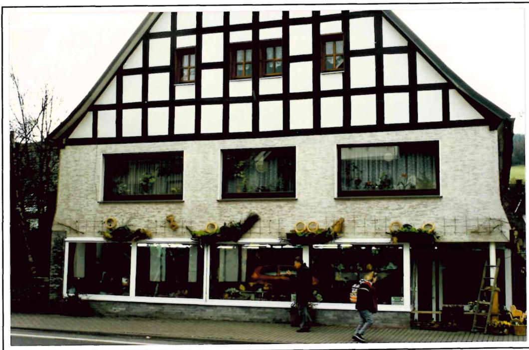
Ein durchgängiges horizontales Scheibenband im Erdgeschoß ist dem Straßenbild dieses Fachwerkgebäude abträglich. Es sollten, genau wie bei normalen Fenstern, stehende Formate verwendet werden, um die senkrechte Fassadengliederung zu wahren
