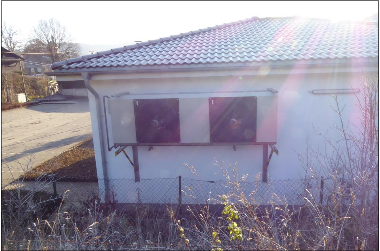
Abbildung 11: Axiallüfterverflüssiger am Messpunkt 2
