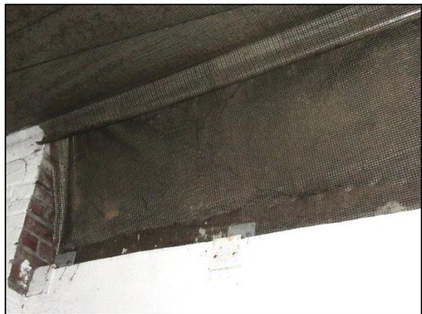
Abbildung 11: Ersichtliche Öffnung, die allerdings von Innen mit einer Dampfsperre verschlossen ist
