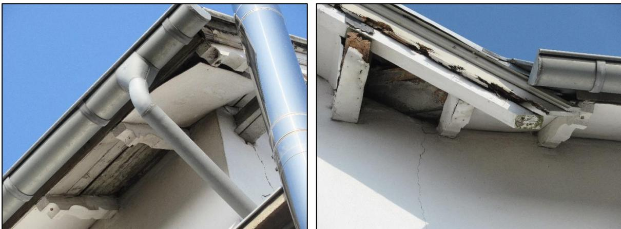
**Abbildung 14: Schädigungen am Dachüberstand**
