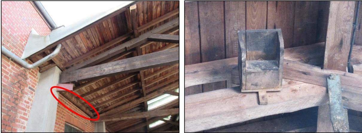
**Abbildung 12: Große Fuge und Nistkasten im Bereich der überdachten Zufahrt**
