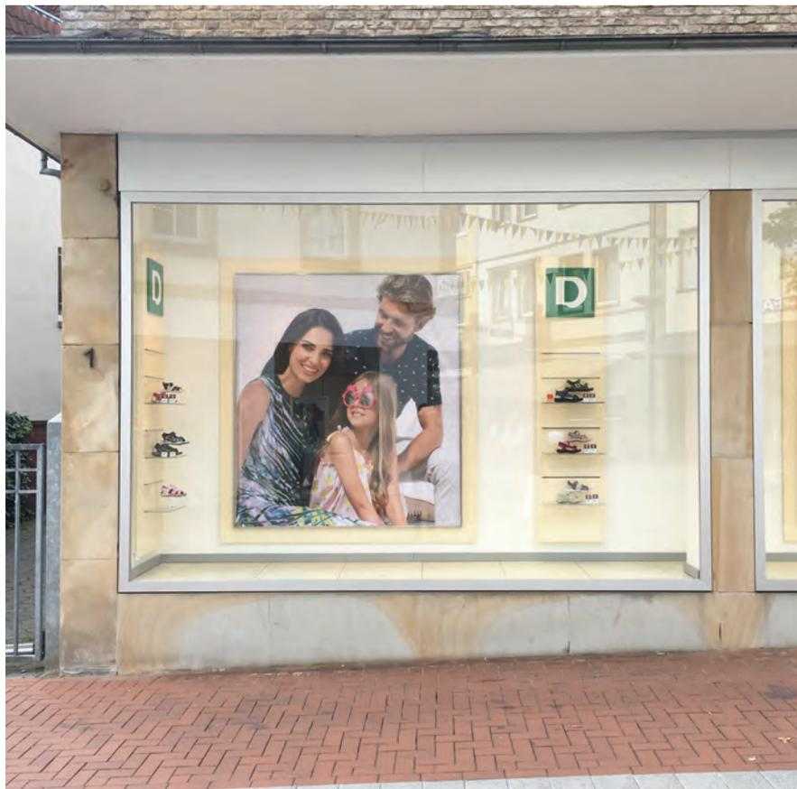
Beispiel für eine im topographischen Verlauf ausgebildete Sockelzone
