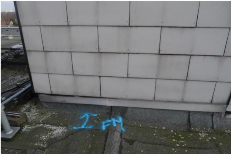
**Abbildung 16: beispielhafte Markierung eines möglichen Einflugbereiches (für die Bauausführung) unter der Verkleidung des Aufzugwartungsaufbaus (wurde im Rahmen der ÖBB kontrolliert)**
