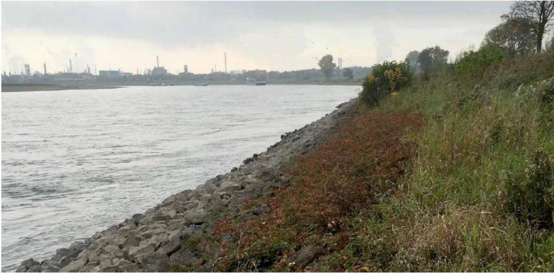
**Abb. 18: Steindeckwerk am linken Rheinufer bei Dormagen (Blickrichtung Süden) (Bildquelle FROELICH & SPORBECK 2015)**
