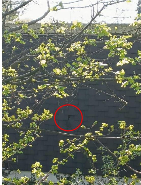
Abbildung 8: Loch (rot markiert) an der mit Schieferplatten verkleideten Fassade der Gartenhofhäuser (ISR 2023)
