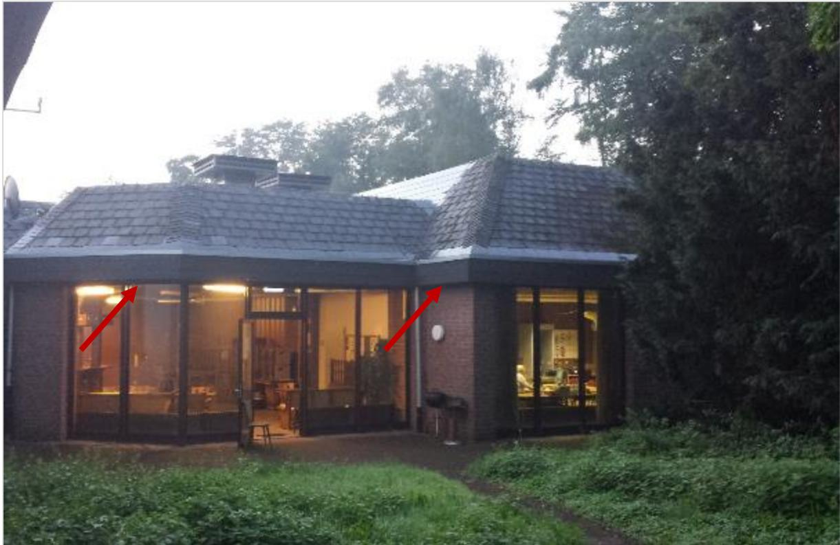
Abb. 5: Weiteres Gebäude mit Einflugmöglichkeiten in den gedämmten Dachbereich
