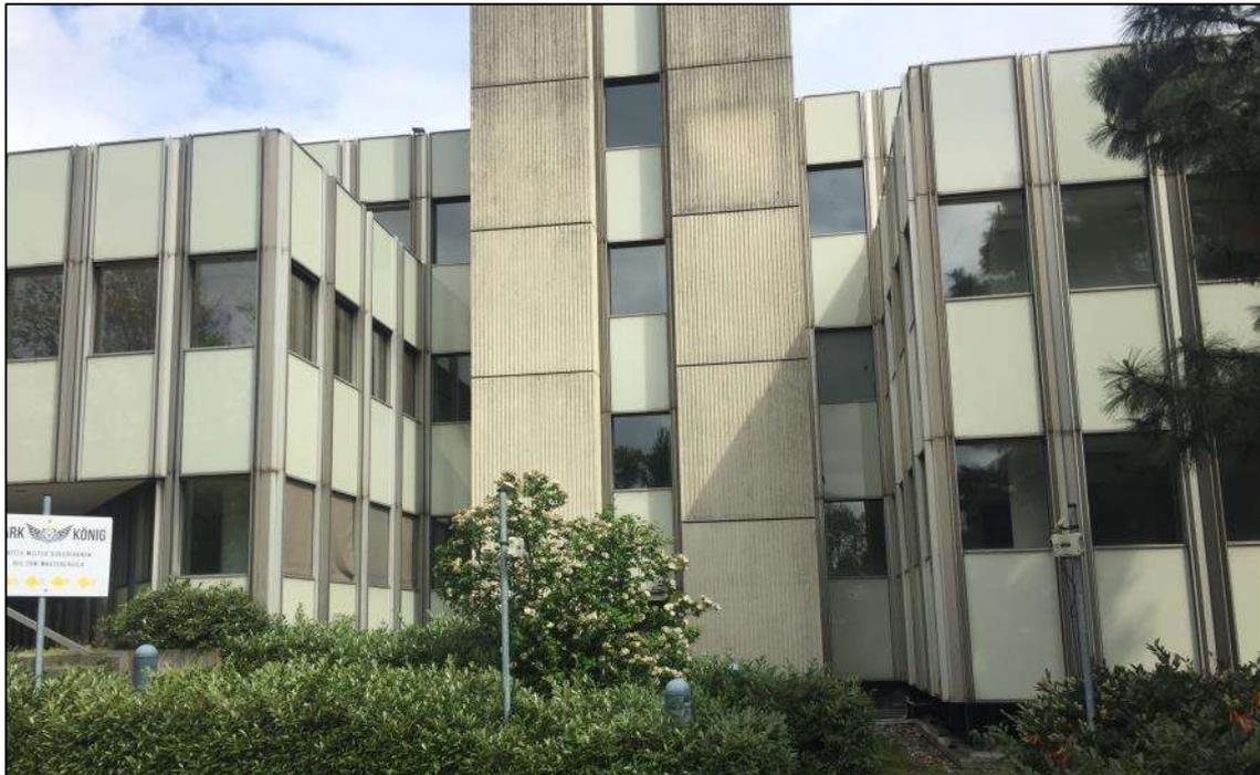
**Abb. 5:** Außenansicht von Fashion House 1 mit Beton/Stein-Verkleidung im Bereich des Treppenhauses.
