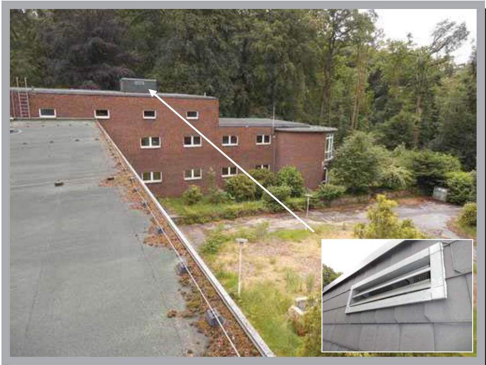
Foto 11: Hauptgebäude 3c – Flachdächer (kl. Foto Lüftungsöffnung Fahrstuhlschacht).
