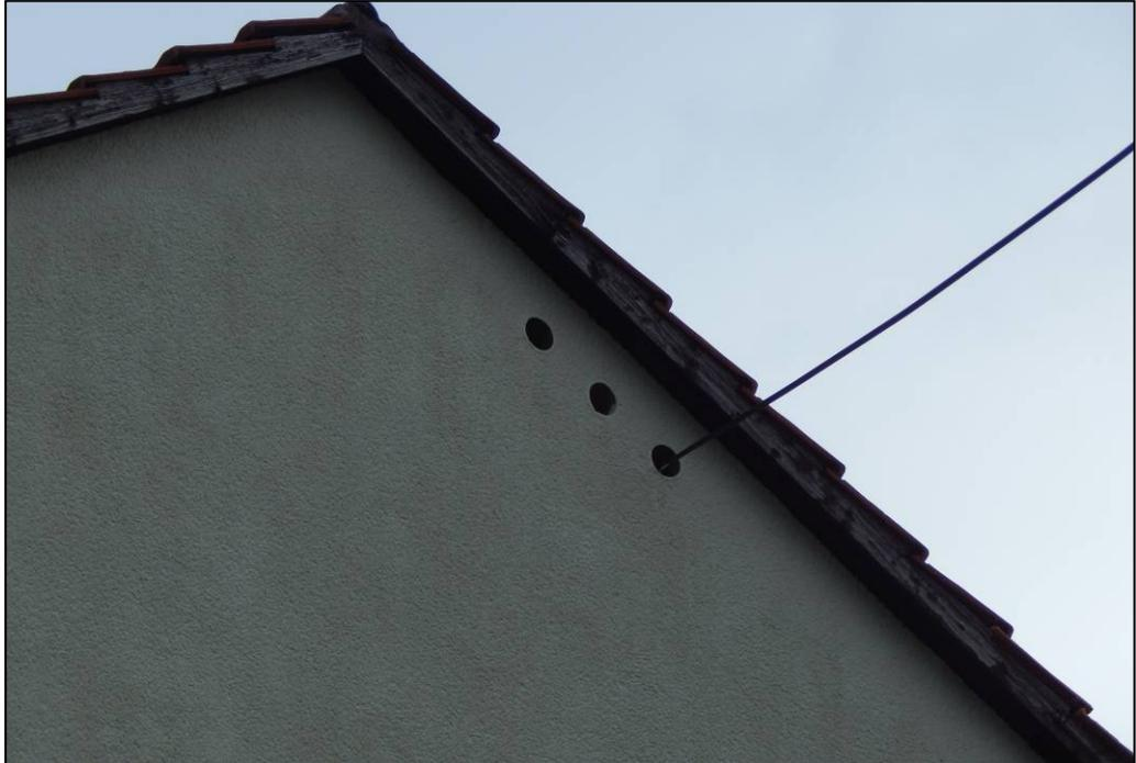
**Dok. Foto 11:** Gebäudetyp E am Niederkasseler Lohweg; im Außenbereich bieten Leerrohre eine Einschulpmöglichkeit zum Dachboden für planungsrelevante Tierarten.
