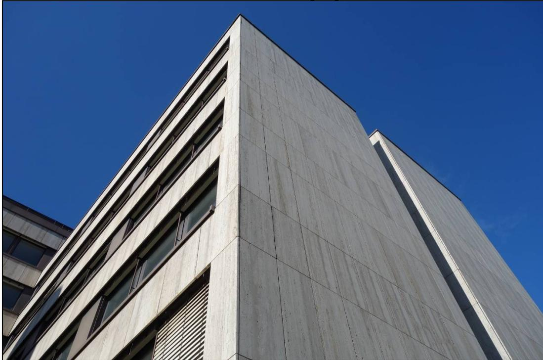
**Foto 6:** Techniketage mit Eternitplatten verkleidet
