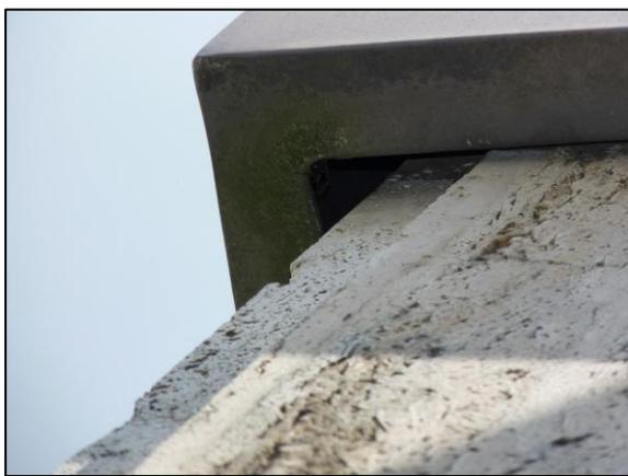
**Potentielle Spalten zwischen Fassadenplatten, Fensterbänken, Isolierung und Außenwand**
