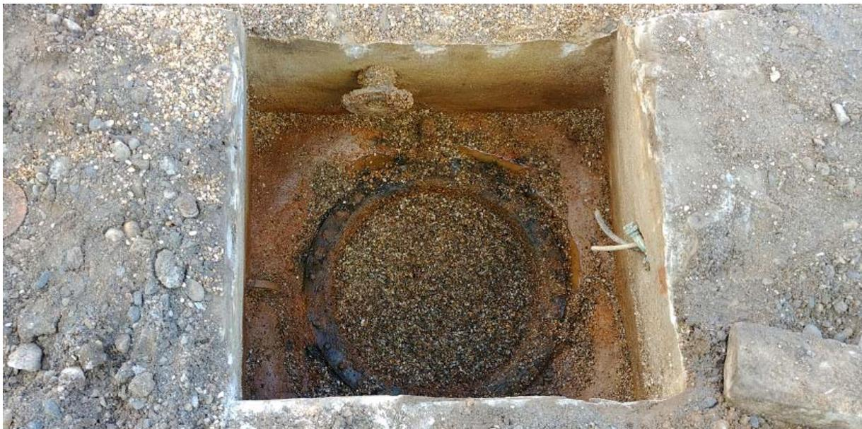
**Foto 2: Blick in Tank 2. Verfüllung mit Rollkies.**
