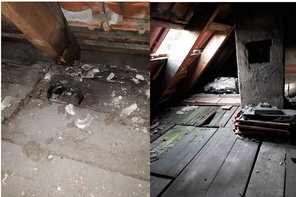
Foto 20: Blick auf den Dachboden des leerstehenden Wohngebäudes mit Steinmarder-Losung (links) und fehlenden Ziegeln im Dach (rechts).
