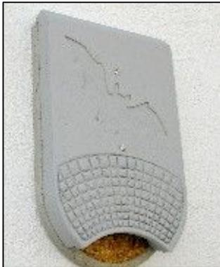
Abbildung 4: Schwegler Fledermaus-Fassadenquartier 1FQ ist aus witterungsbeständigem und atmungsaktivem Holzbeton gefertigt. Das Fassadenquartier hat eine Größe von Höhe 60 x Breite 35 x Tiefe 9 cm und ist als Spaltenquartier geeignet. Die Befestigung erfolgt mit vier Schrauben. (Quelle: SCHWEGLER Vogel- und Naturschutzprodukte GmbH).
