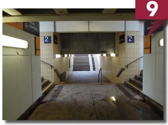
fehlende Barrierefreiheit im Verteilertunnel und an den Gleiszugängen: keine Aufzüge, keine Rampen
