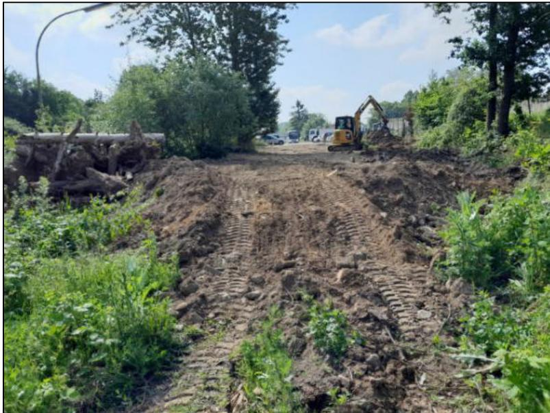
Abbildung 52: Stetige Vergrößerung der Rampe, Veränderung des Bodenniveaus.
