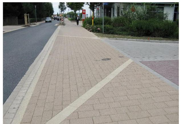
Abb. 4 Beispiele für die Ausführung einer Gehwegüberfahrt
