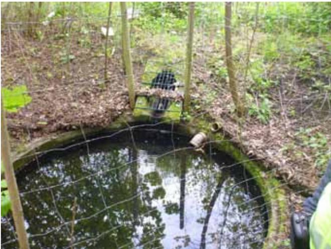
Foto: Einlauf DN 400 mit Stabgitter und Ablauf DN 125
